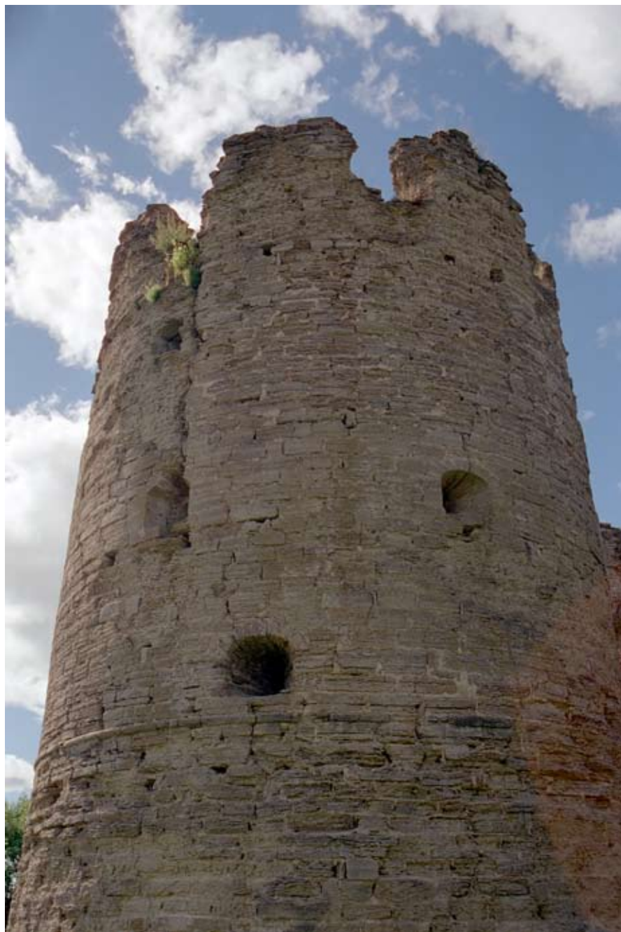
Южная воротная башня Yujnaya Vorotnaya tower
