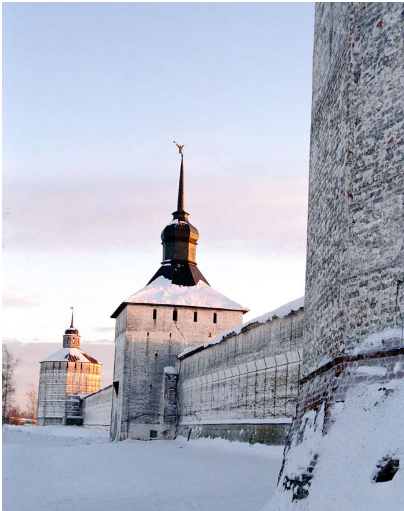
Восточная стена с Казанской башней The eastern wall with Kazanskaya tower
