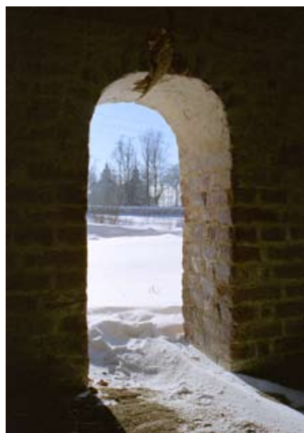
Вход в помещение подошвенного боя стены Нового Города Entrance into the lower floor of Novy Gorod wall
