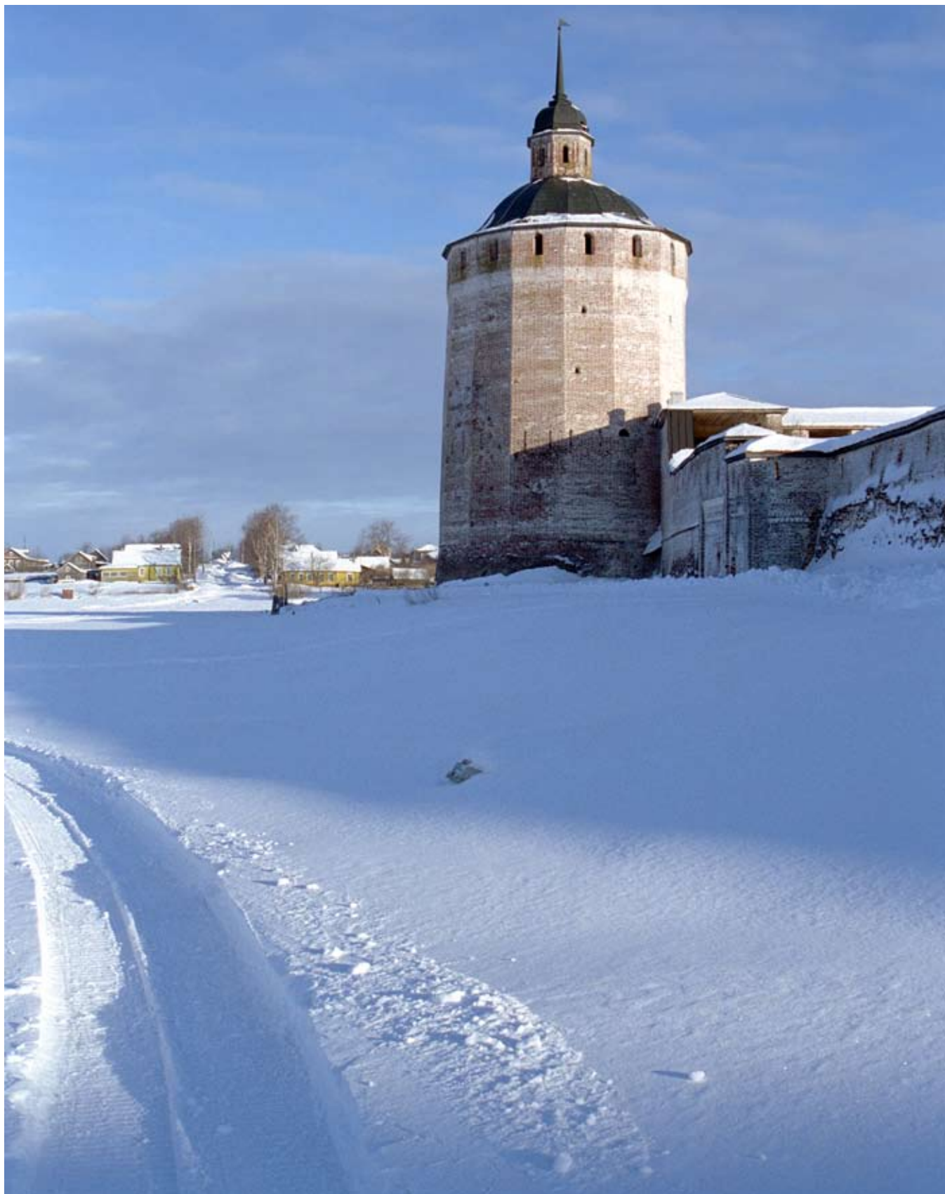
Белозерская или Большая Мережненная башня Belozerskaya or Bolshaya Merejennaya tower
