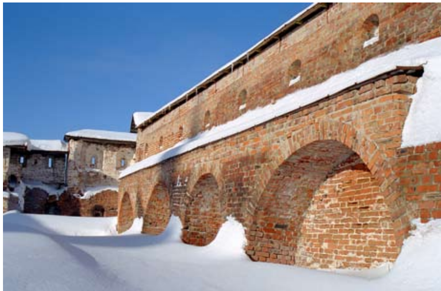
Участок ограды Ивановского монастыря Wall of Ivanovsky monastery fence
