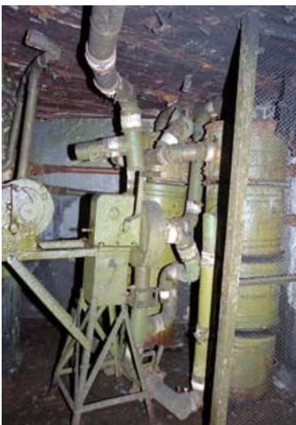
Фильтровентиляционная установка пулеметного дота
