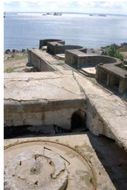
Позиции 45-мм орудий 1940-х гг., устроенные поверх брустверов 1900-х гг.
