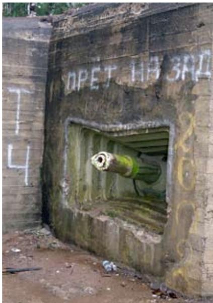
Двухорудийный АПК в Меднозаводском БРО. Стволы спилены на металлолом в начале 2000-х гг.
